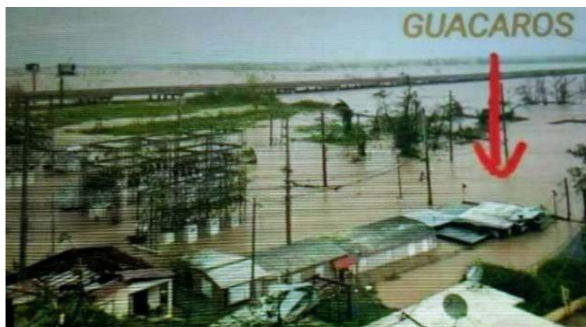
Figura 4-2. Inundación de subestación en Dorado
