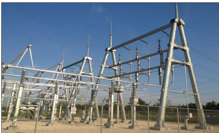
Figura 6-3. Estación de adiestramiento con cuarto de control y equipos
