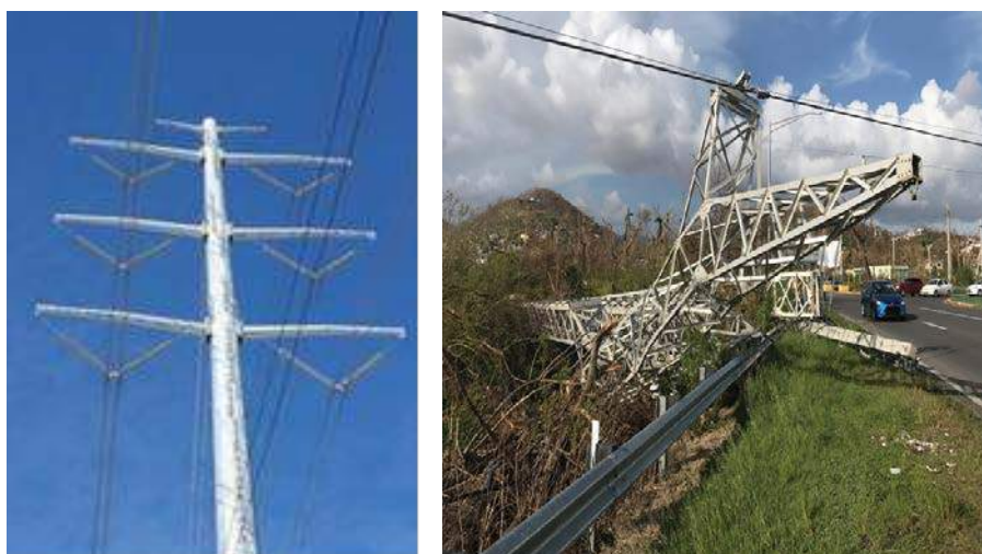
Figura 4-5. Diseño de monopostes vs. torres de celosía
