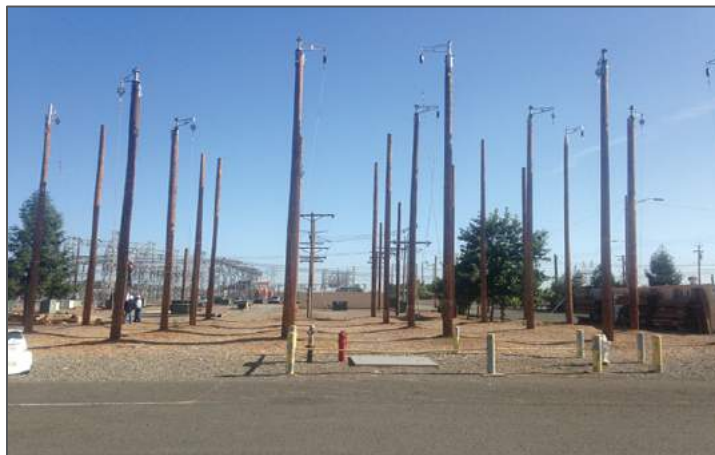
Figura 6-4. Campo de adiestramiento con instalaciones (T/D aérea y soterrada)
