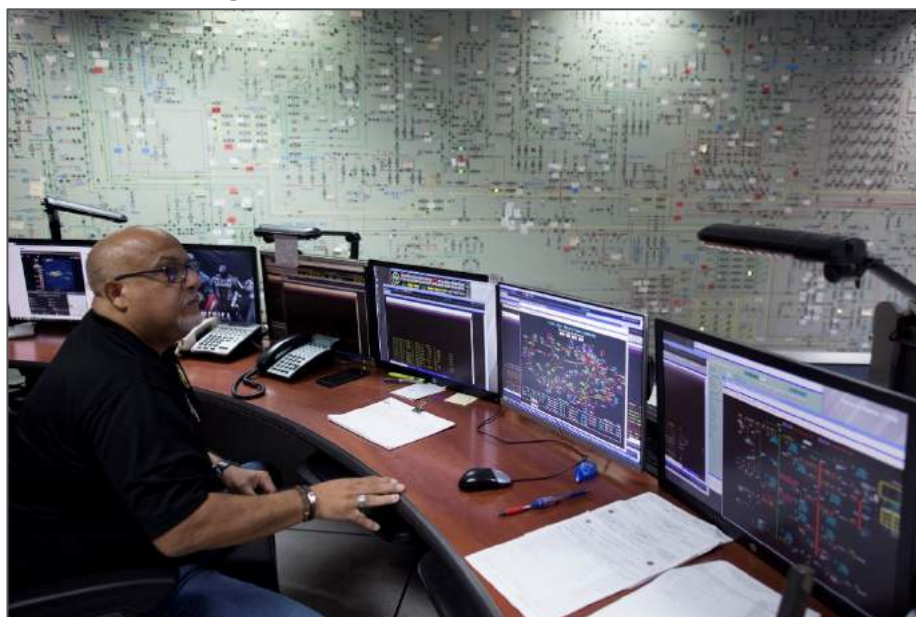
Figura 2-2. Centro de Control de Monacillo
