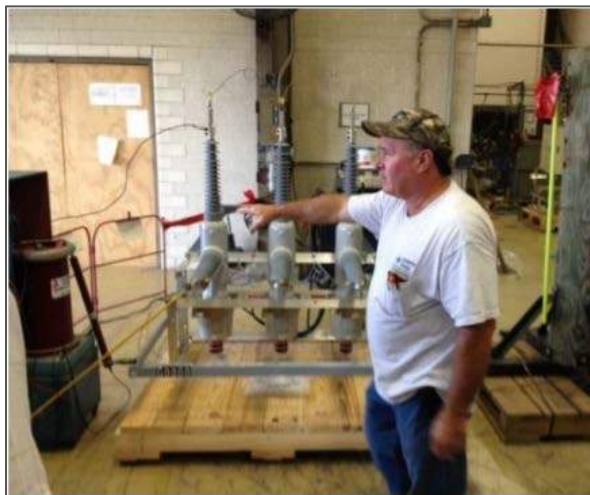
Figura 6-2. Ejemplo de instalación de prueba de reconectadores en CenterPoint Energy
