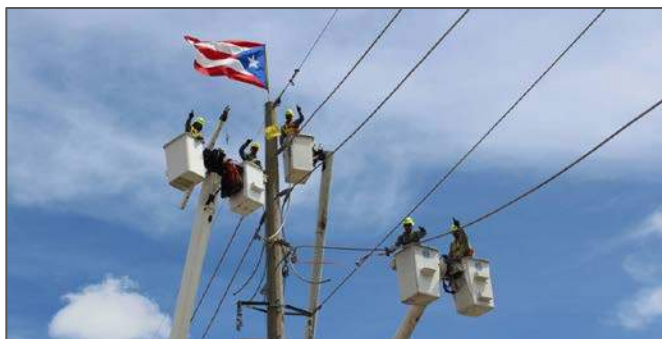
Figura 4-7. Reparaciones en líneas de distribución
