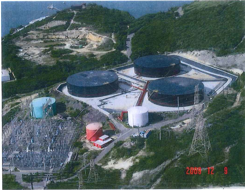
Patio de Interruptores 230kV
