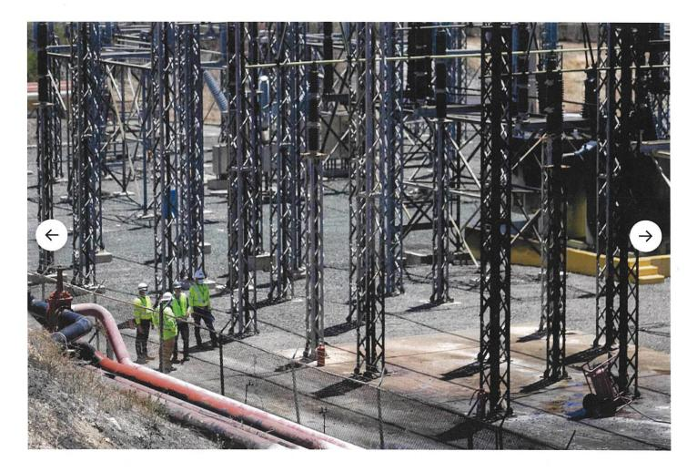
1/16 | Así quedó la zona de interruptores en la central Costa Sur tras el incendió que provocó el apagón general. Las imágenes muestran el estado en el que quedó la zona de interruptores de la central Costa Sur tras el incendio que provocó el apagón general cerca de las 8:30 p.m. del 6 de abril de 2022. - *Jorge A. Ramírez Portela*
